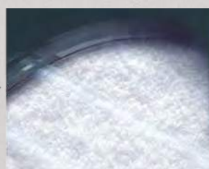
Обмерзание теплообменника
