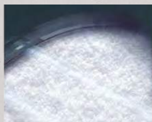
Обмерзание теплообменника
