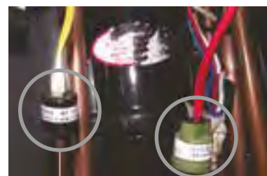
Выключатель низкого давления
